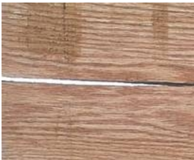
FENTE, GERCE : Séparation longitudinale du bois causée par son séchage. Le terme de « Shake » désigne une séparation des anneaux de croissance.
